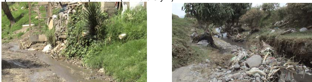
Foto 3 y 4: Descarga de aguas residuales al arroyo. Arrastre de basura, piedras y troncos.
