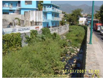
Figura 8. Hierba, maleza y aguas residuales
