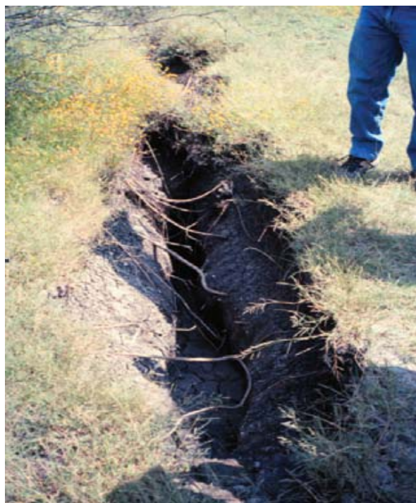
Foto 2. Grieta por subsidencia ciudad de Salamanca, Guanajuato, México (Rodríguez-Ramírez, 2006: 266)
